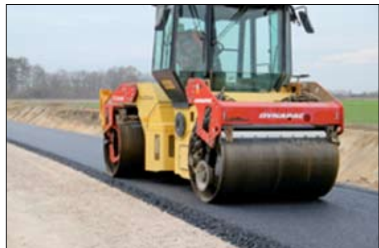
Fot. 1 Odcinek testowy (fot. Budimex S.A.)
